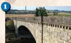
Pont sur la Broye 46.705305 / 6.8436275
